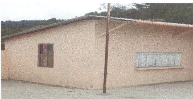
Foto 3: Sustrucción de Ventana de madera por metal mas vidrio
